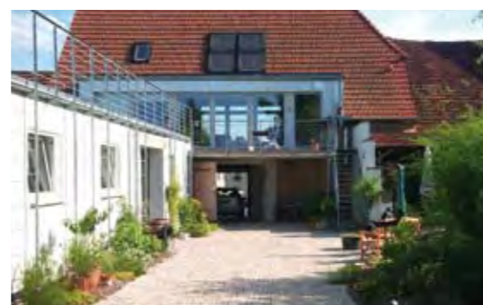
Das neu entstandene Passivhaus hat jetzt eine Solaranlage und eine Soleanlage zur Erdwärmennutzung.
